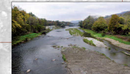
Trotz Wehranlage soll eine Dynamik möglich werden
